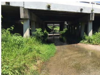
รูปที่ 2-7: การเทคอนกรีตบริเวณตลิ่งและพื้นที่รองรับน้ำห้วยกะปิ
